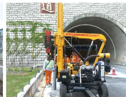
福建施工 Construction site in Fujian
