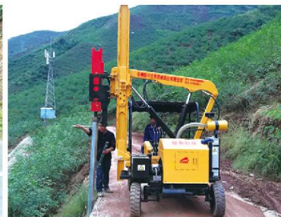
江西施工 Construction site in Jiangxi
