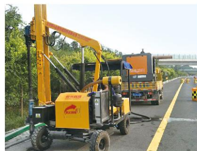
陕西施工 Construction site in Shanxi
