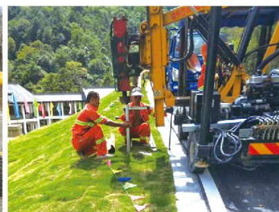
广东施工 Construction site in Guangdong
