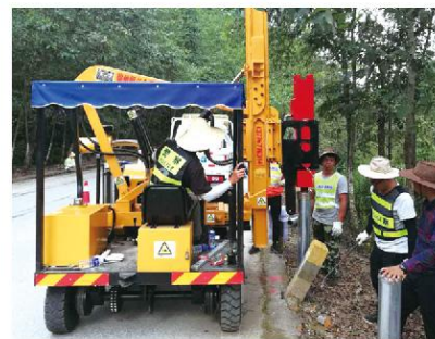
重庆施工 Construction site in Chongqing
