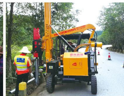
广西施工 Construction site in Guangxi
